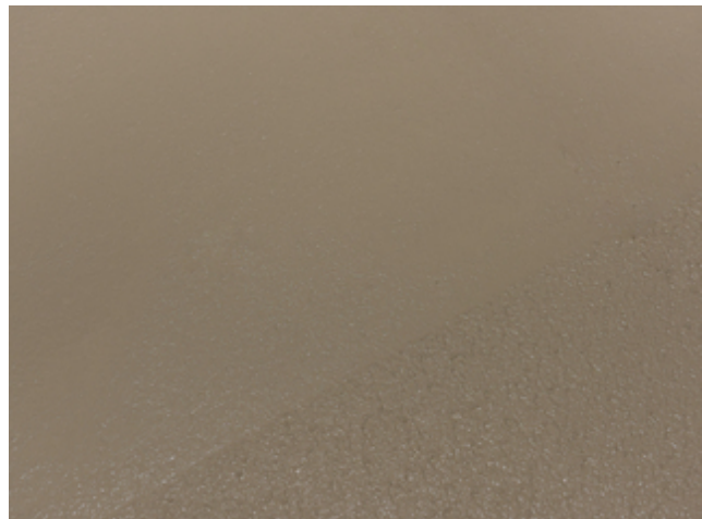
4. Somit werden Kellenschläge und Lunker vermieden.
