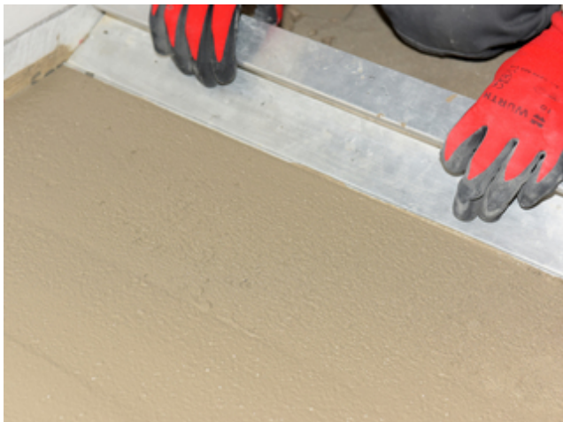
3. Selbstheilungseffekt durch selbstständiges Verdichten des Materials.
