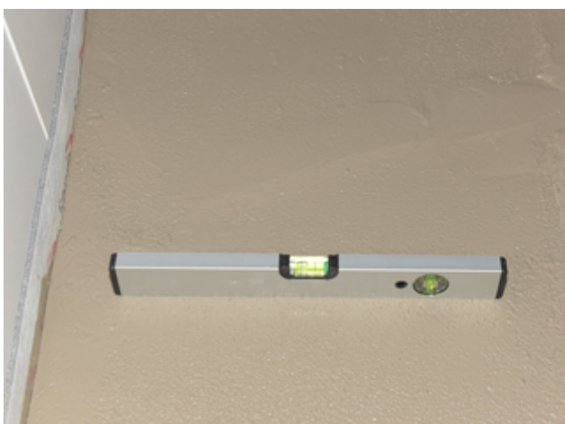
5. Gefälle mit Neigung zum Abfluss.
